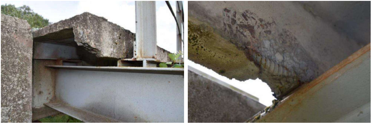
2.17 pav. Šaltilčio plokščių defektai: nuskilinėjusios, ištrupėjusios plokščių briaunos, atvira, korduojanti armatūra
