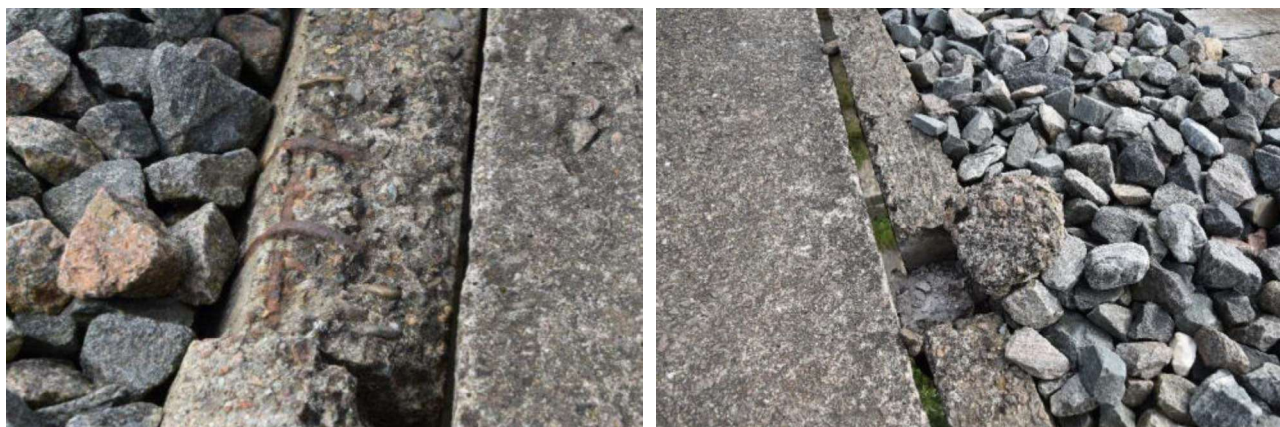
2.1 pav. Atšokęs ir ištrupėjęs betonas plokščių viršuje
