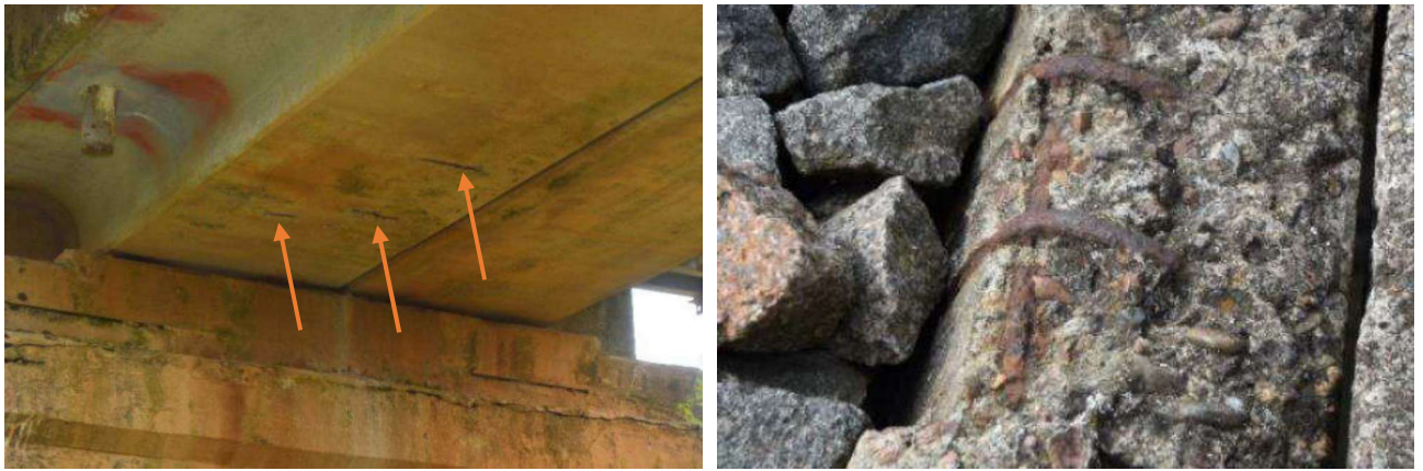
2.2 pav. Atvira, koroduojanti armatūra
