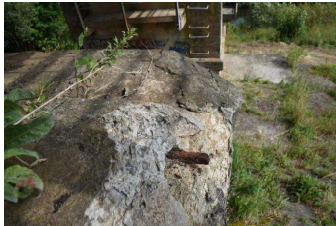
2.11 pav. Atvira, koroduojanti armatūra
