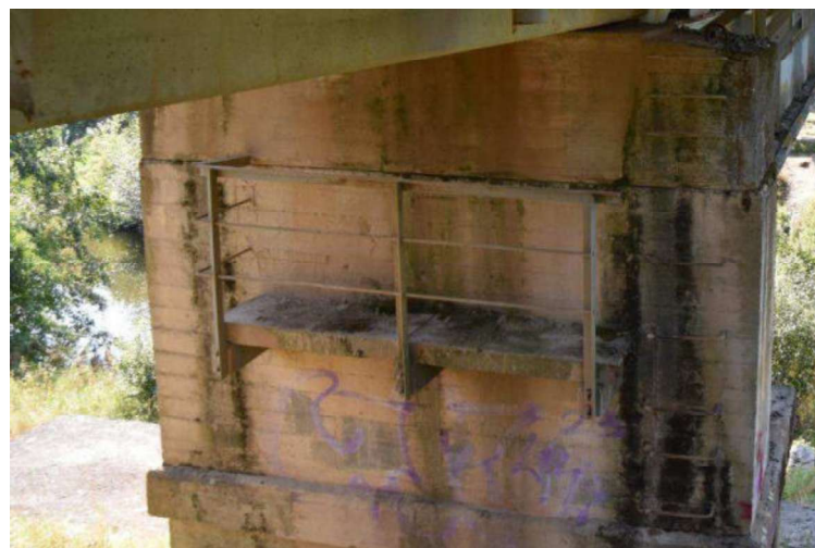
2.13 pav. Kiauri deformaciniai pjūviai, matomos vandens pratakos, išplauti cementinio akmens elementai
