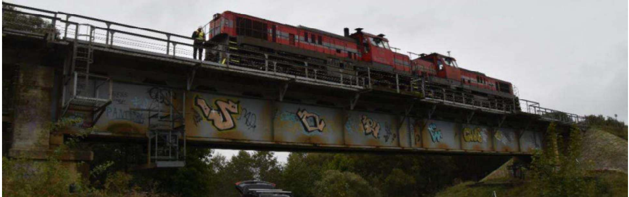
3.8 pav. Statinių bandymų eiga: šilumvežiai III padėtyje
