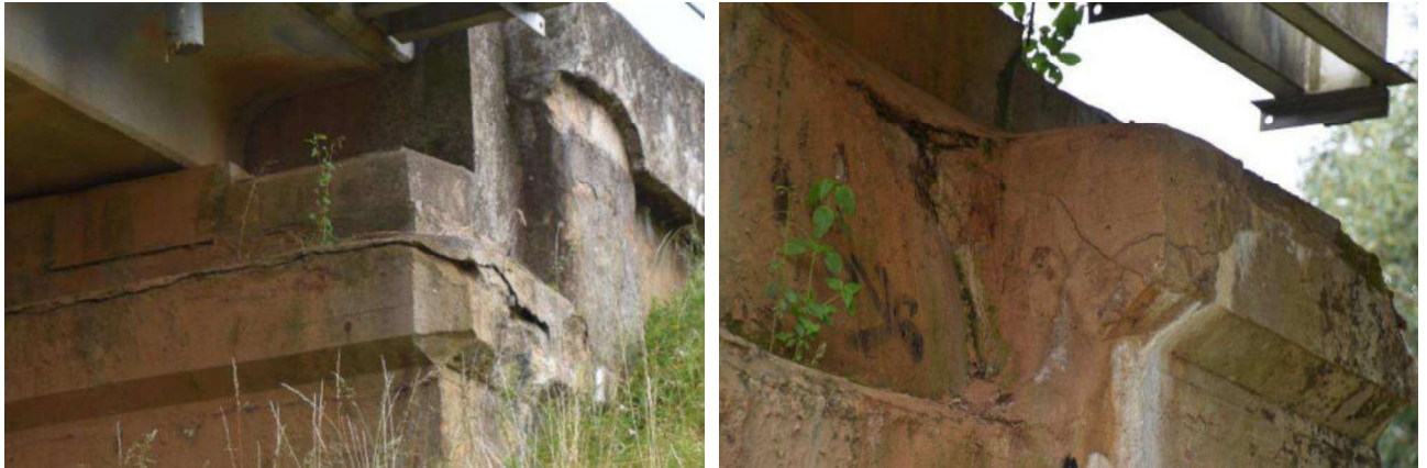
2.10 pav. Plyšiai atramose, ištrupėjęs betonas
