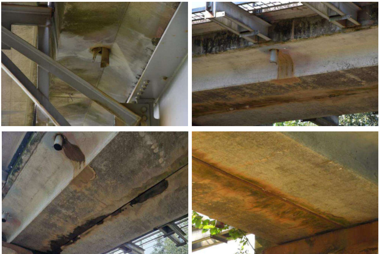
2.5 pav. Kiaura perdangos hidroizoliacija, matomos vandens pratakos, išplauti cementinio akmenų elementai
