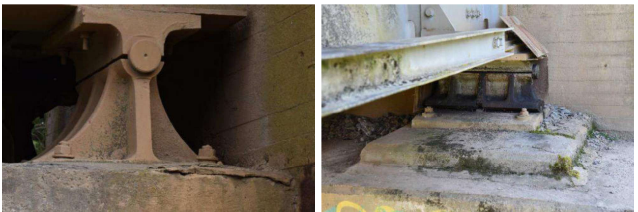
2.9 pav. Atsilaisvinę guolių tvirtinimo varžtai, atšokęs betono sluoksnis, nėra dalies apsauginių uždengimo plokštelių
