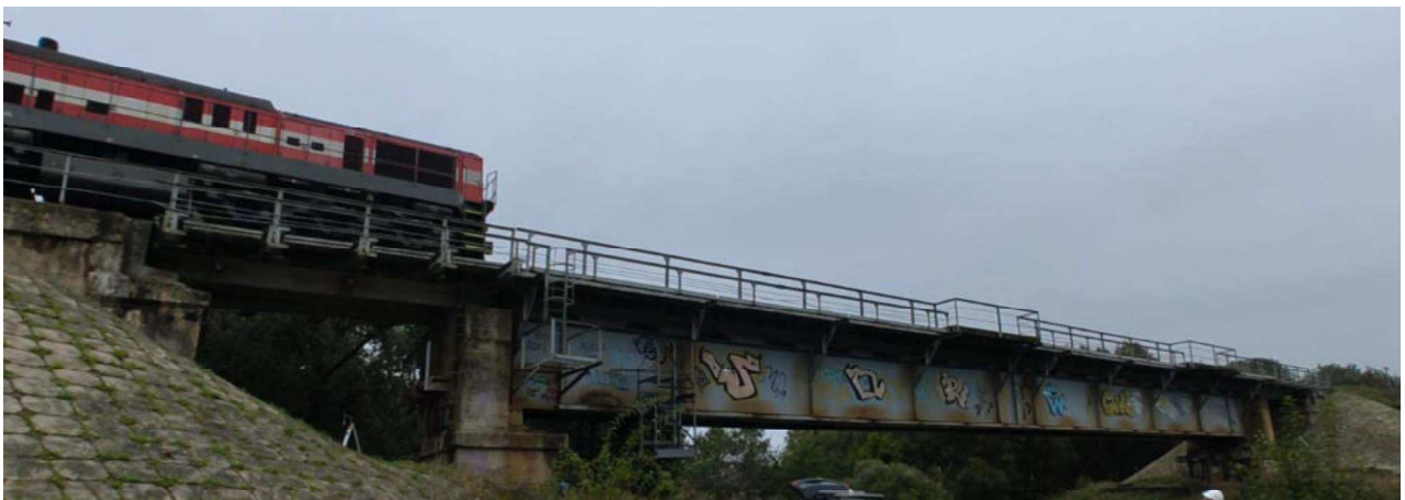
3.4 pav. Statinių bandymų eiga: šilumvežiai I padėtyje
