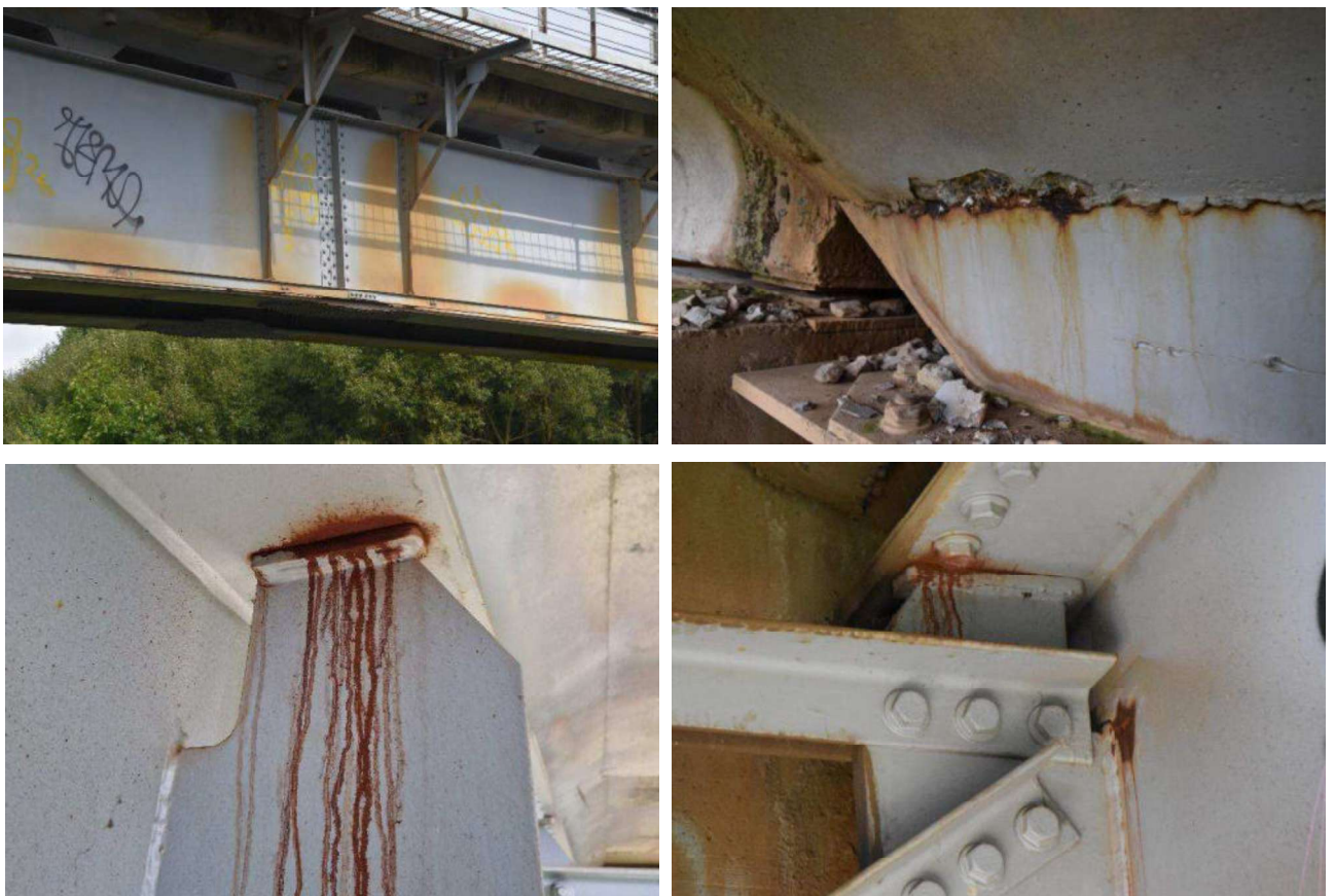
2.7 pav. Paviršinė sijų elementų korozija bei korozijos židiniai elementų jungimo, virinimo vietose
