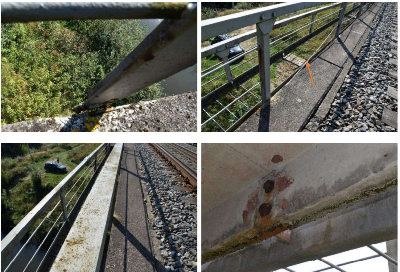
2.18 pav. Turėklų paviršius apkerpėjęs, kai kurie statramsčiai nepritvirtinti prie perdangos, matoma tvirtinimo varžtų korozija, sulankstyti, atitrūkę turėklų elementai
