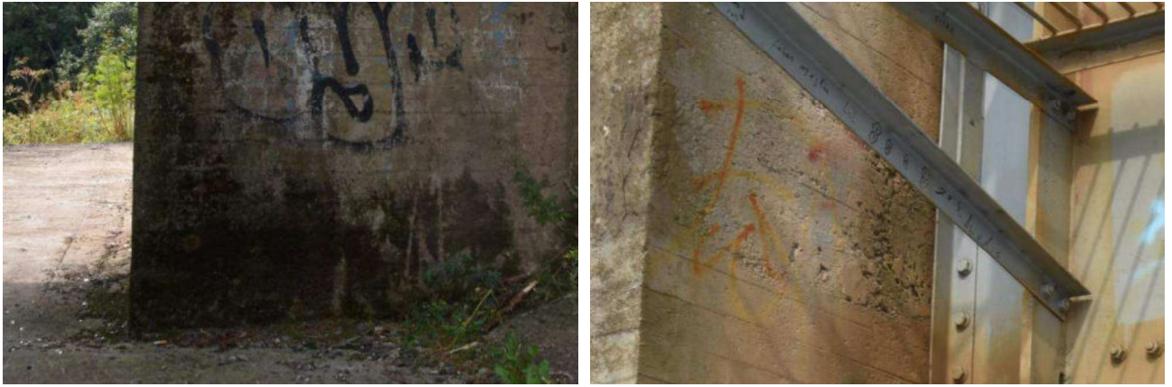
2.12 pav. Apsamanojęs betono paviršius, vietomis nepakankamai sutankintas, porėtas betonas
